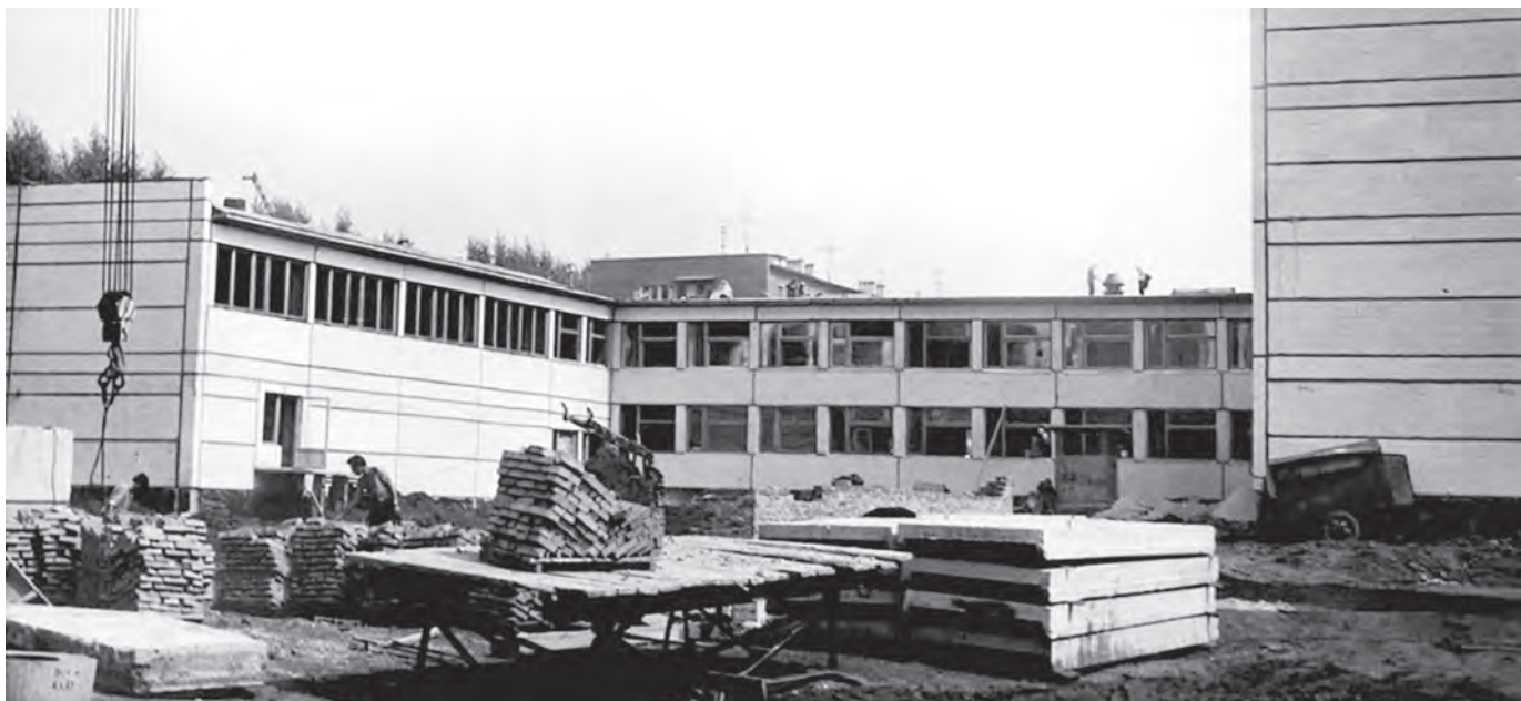
Возведение нового здания средней школы № 74.
