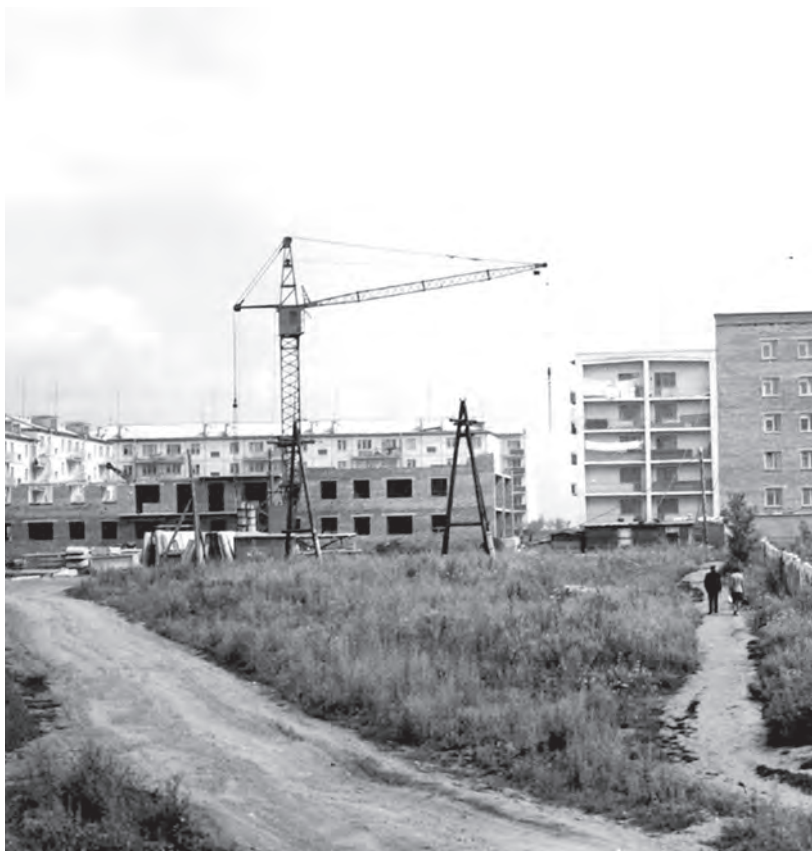
Строительство 21-го микрорайона.
