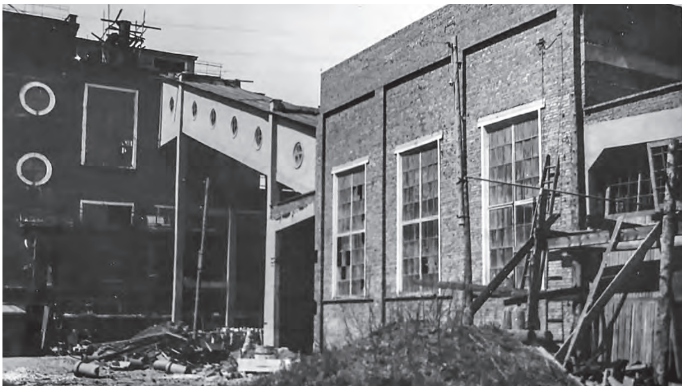
Строительство здания цеха №1.
